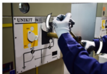
جهت چرخش دسته برای تغییر وضعیت کلید از قطع به وصل
