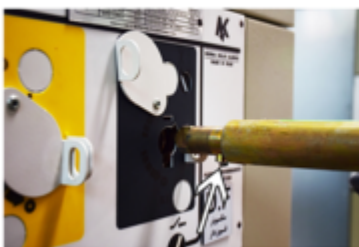
جهت قرار دادن پین برای تغییر وضعیت کلید از قطع به وصل
