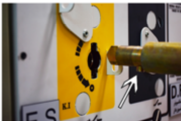
جهت قرار دادن پین برای تغییر وضعیت کلید از قطع به ارت
