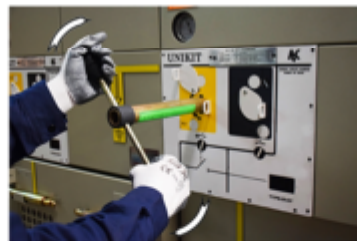
جهت چرخش دسته برای تغییر وضعیت کلید از قطع به ارت
